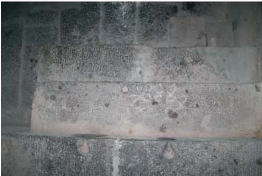
Kannimoolai thiruchutru Maligai padikattu (Vatteluthu) (South western corner prakara steps)
